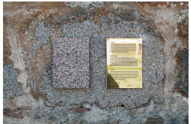
Graniittilaatta juuri asennettuna 2019
